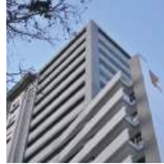
Torre ACSA Santiago de Chile 1320. 7.220m 2 50 apartamentos
