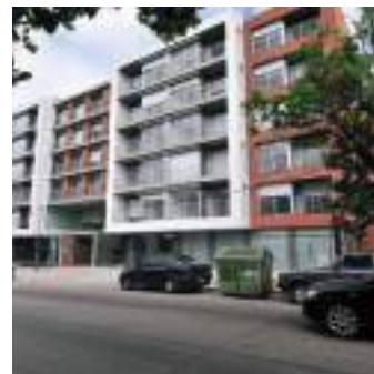
Ventura Tres Cruces Monte Caseros 2647 esq. Garibaldi. 7.250m 2 102 apartamentos
