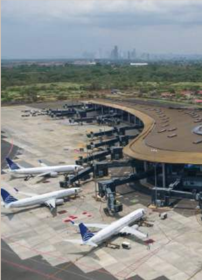
Nueva terminal aérea / Tocumen US $1 Billon aprox.
