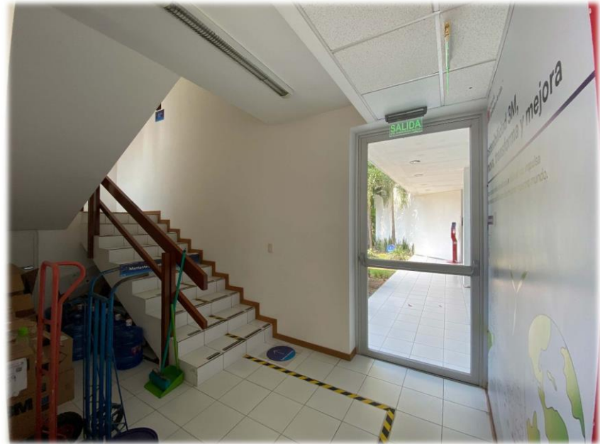
Vista del acceso a escalera
