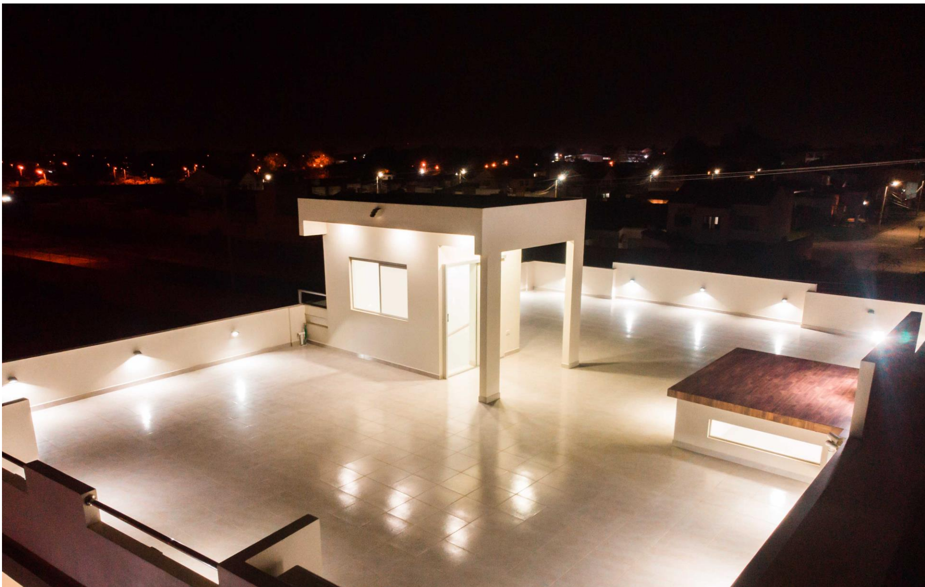
Terraza en tercer piso
